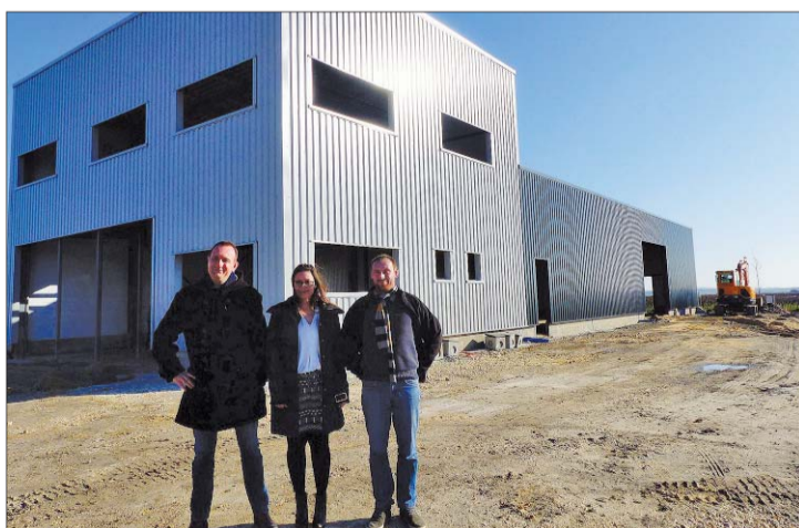
Bertrand Faurie, patron d'Homnia (à gauche), devant le chantier en cours. Photo CL
